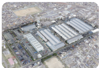
本社事業所 敷地面積 125,000㎡ / 建物面積 54,000㎡
