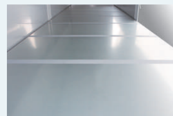
●床上張り 亜鉛引き鉄板
