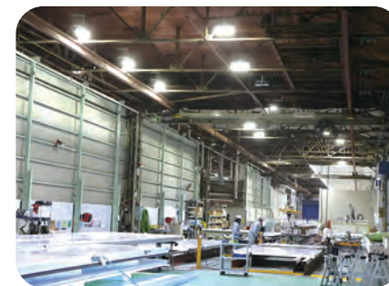
音羽事業所メラミン塗装ブースのLED化
