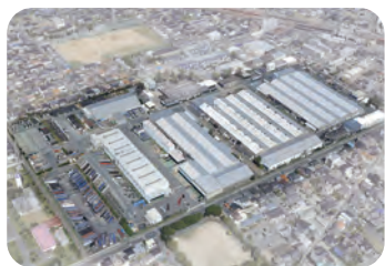
本社事業所 敷地面積 125,000㎡ / 建物面積 54,000㎡
