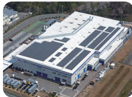
音羽事業所屋上の太陽光発電パネル
