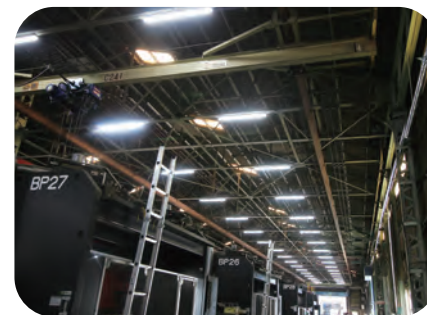
本社A工場の照明LED化
