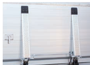
アルミ縞板取付 (写真はスチフナ+先端部取付)
